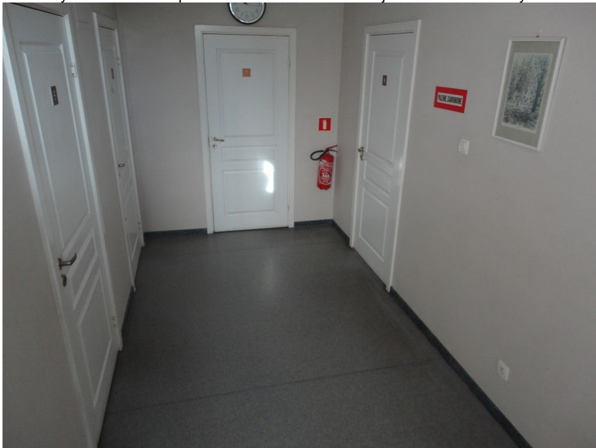
Nr 5 – Wymiana drzwi do apartamentów z klatki schodowej na EI30 z samozamykaczem
