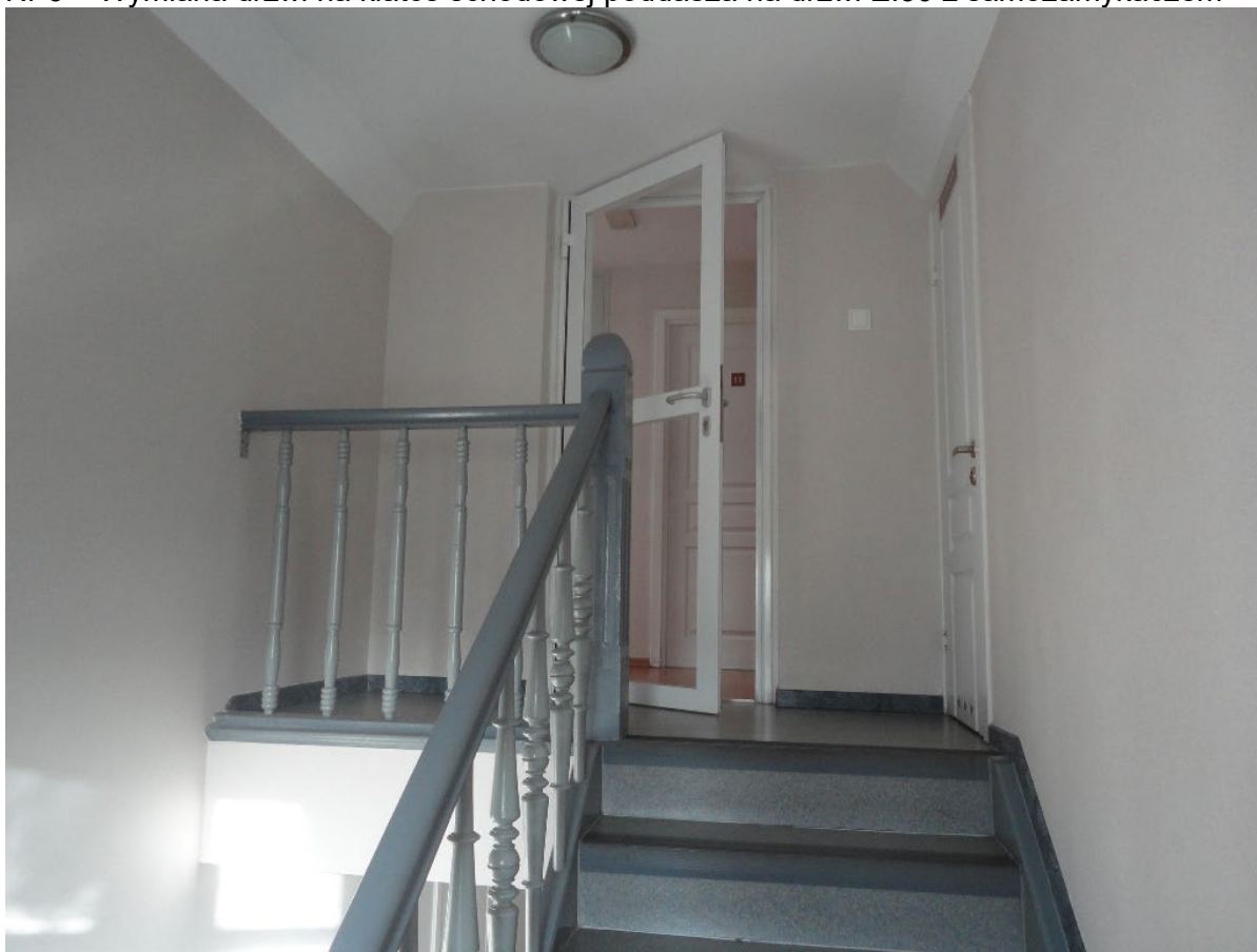
Nr 6 – Wymiana drzwi na klatce schodowej poddasza na drzwi EI30 z samozamykaczem
