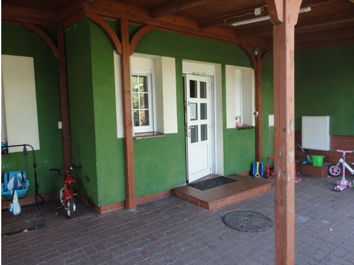
NR 7 – Wymiana drzwi zewnętrznych na nowe o szer. 90cm
